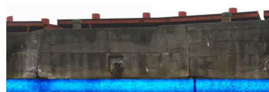
図10 ARIS撮影画像例（護岸モザイク）
